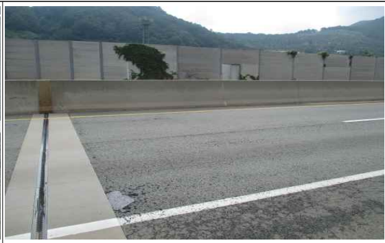
교면포장 하행선 A1측 접속도로 라벨링
