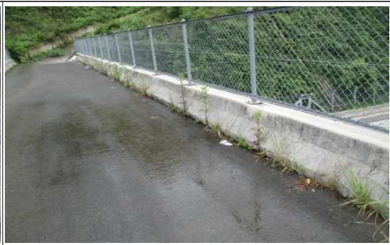
교면포장 S1 식생
